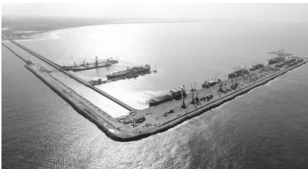
Vista aérea do Porto do Pecém.
